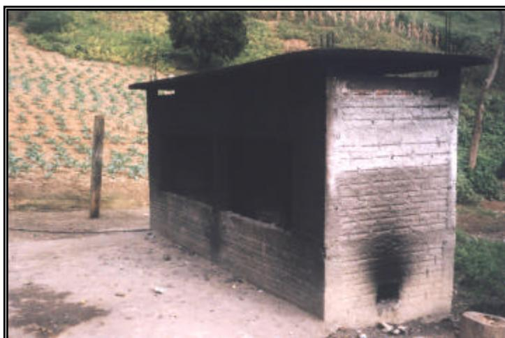
**Foto 3.6.13** – Forno para incineração do lixo
